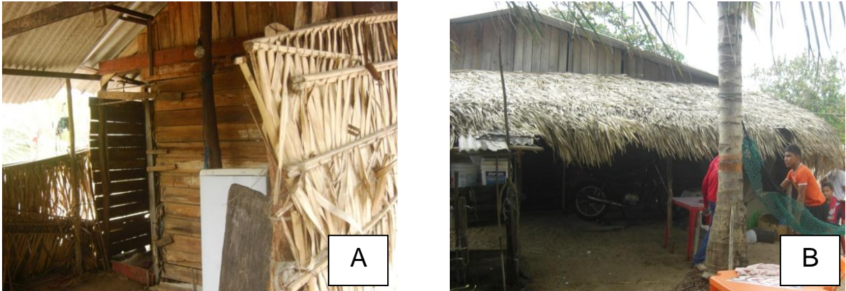
Figura 1. Moradias da comunidade Canto, município de Raposa, Ilha de São Luís-MA: (A) visão interna; (B) construção de madeira, coberturas de palha ou telha de amianto.
